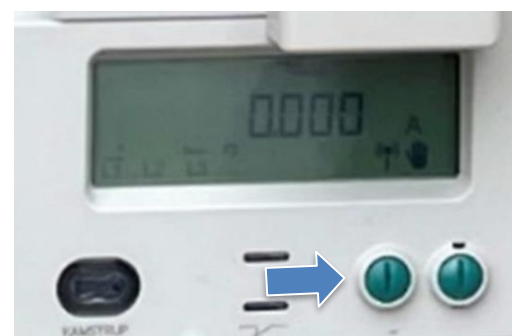
Figur 2: For å få denne visning trykk 2 gangar på venstre knapp. (NB! Dette displayet viser at anlegget ikkje har jordfeil, 0.000 A.)
